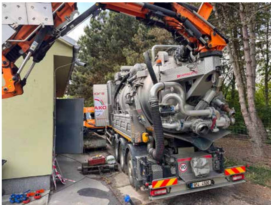
Těžká technika během prací na intenzifikaci ČOV
