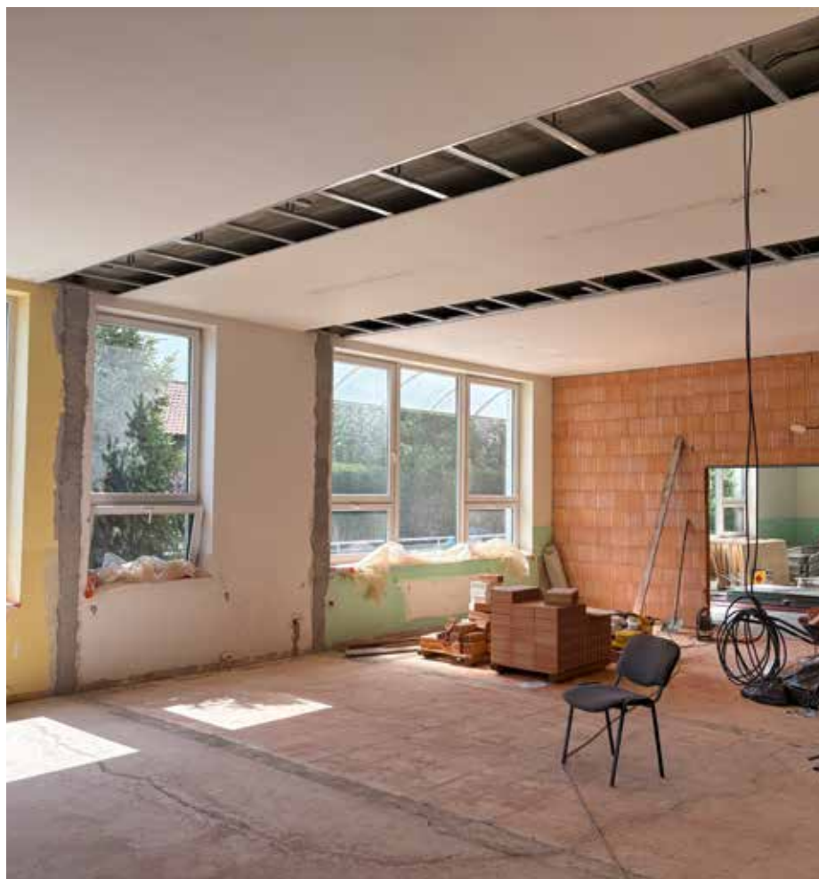
Rekonstrukce školní jídelny
