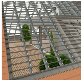
TERASA BYTU UKRYTÁ POD STŘEŠNÍ KRYTINOU
