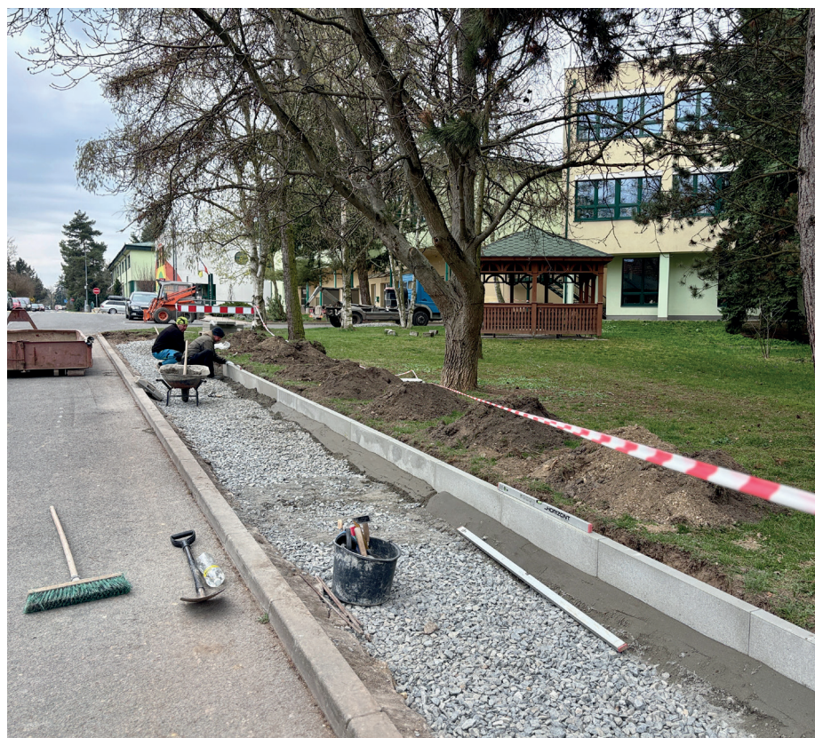
Stavba nového chodníku
