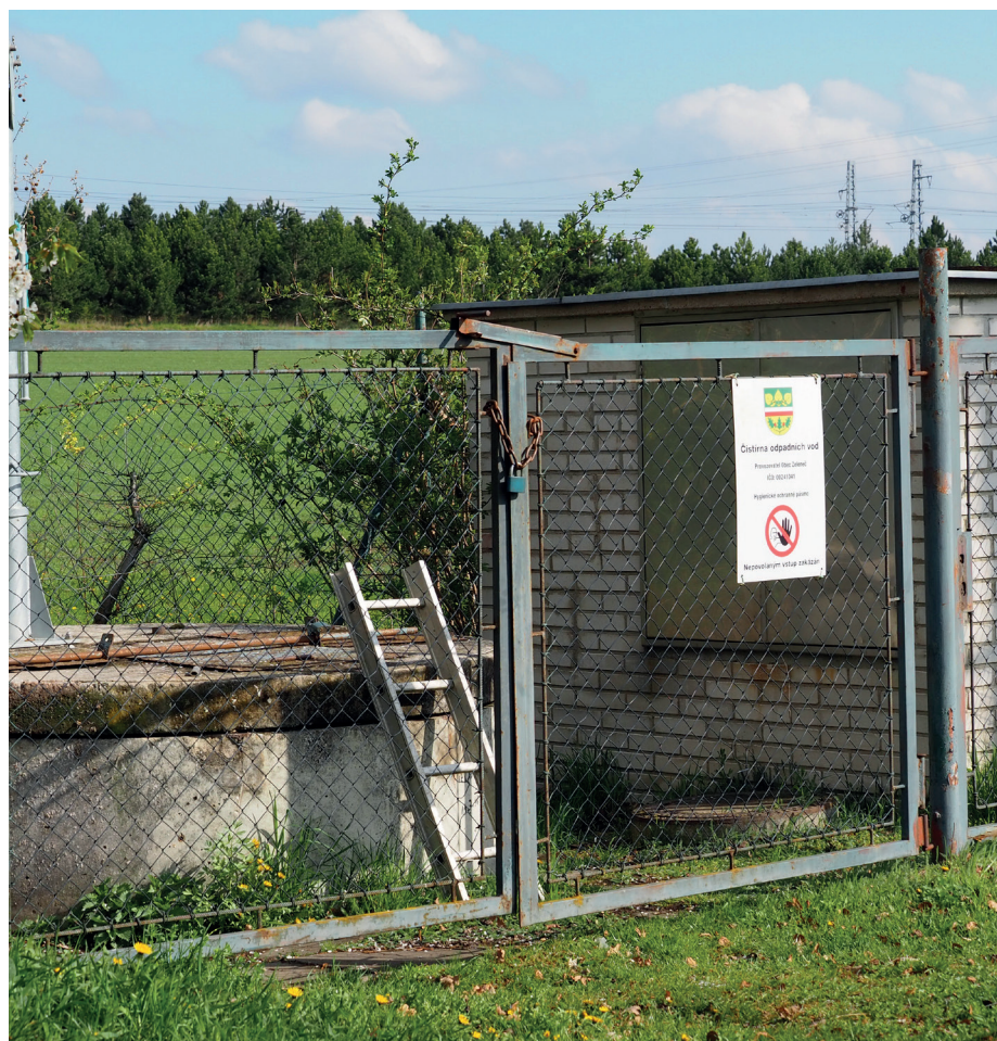
Současná čerpací stanice odpadních vod v ul. Olšová
