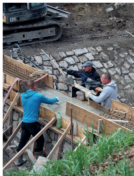
Práce na přehrážce Zelenečského potoka
