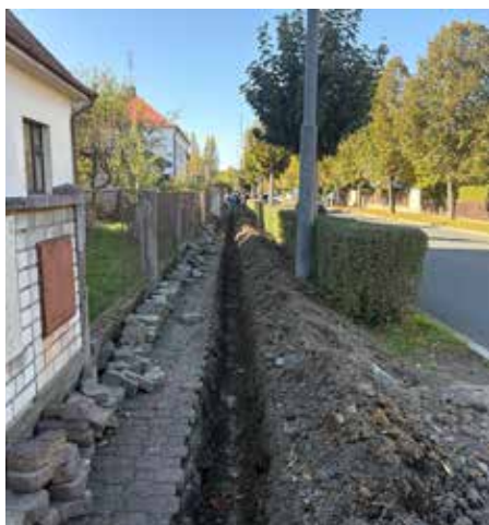
Práce na výstavbě optické sítě v ulici Bezručova
